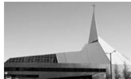
Tallinna metodistide kirikuhoone valmis vahemikus 1995–2000 Pärnu Agape kiriku eeskujul
